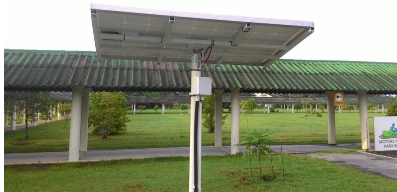
ภาพที่ 6 การติดตั้งแผงวงจรโซลาร์เซลล์เพื่อเป็นพลังงานทดแทนพลังงานไฟฟ้า
