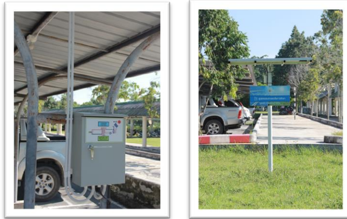
ภาพที่ 4 และภาพที่ 5 การติดตั้งตู้ควบคุมและแผงวงจรโซลาร์เซลล์บริเวณโรงจอดรถ
